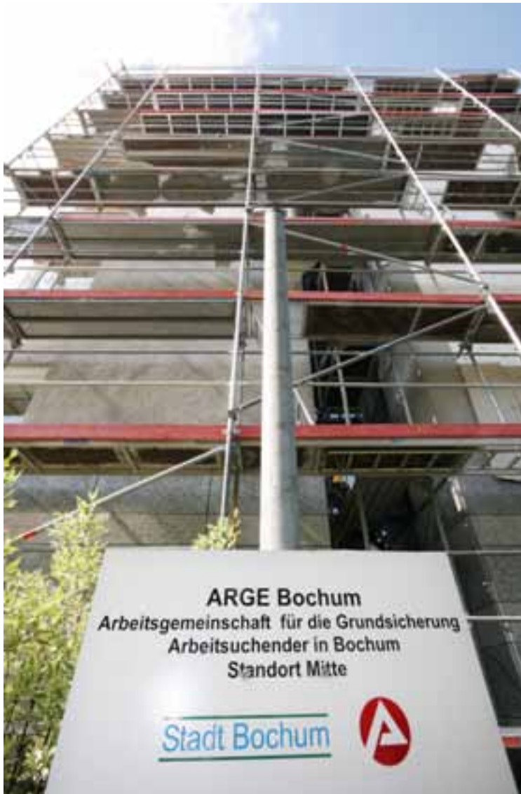
Ewige Baustelle - die ARGE. Eine klare Linie ist nur beim Gerüstaufbau außerhalb des Gebäudes zu erkennen.
