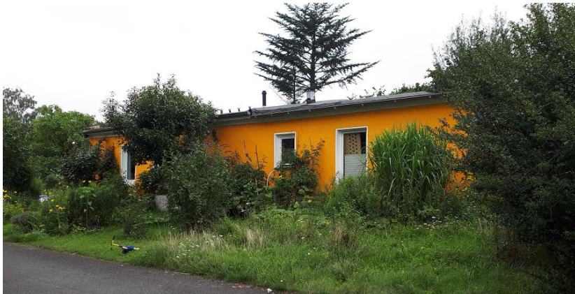
ehem. Zwangsarbeitersiedlung der Zeche Lothringen, August 2023
