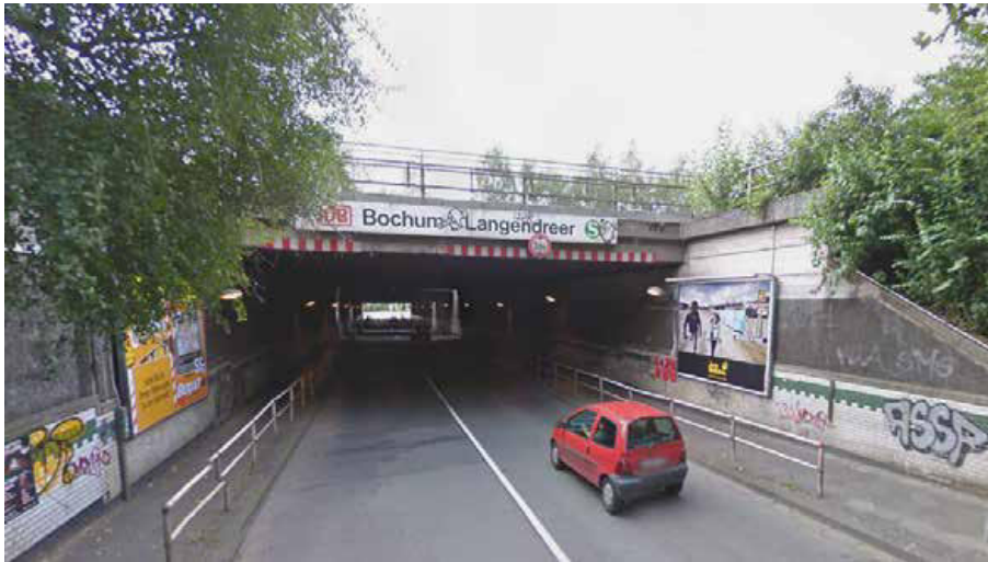
Brückenbauwerk am S-Bahnhof Langendreer
