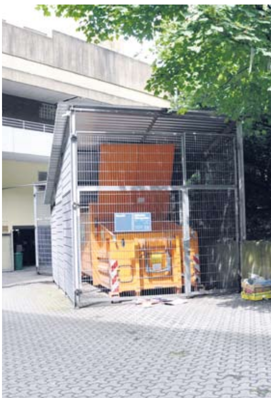
Die Gewerbe-Müllstation im Eingangsbereich und mitten zwischen den Wohnungen stinkt unendlich und die Müllpresse lärmt.
